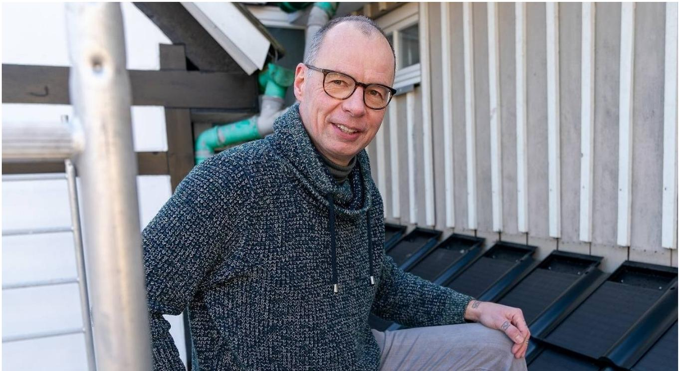
Die von Peter Hakenberg entwickelte Solardachpfanne hält einem Druck von 150 Kilo stand und ist laut TÜV-Rheinland „extrem hagelschlagsicher und sturmsicher“. Hakenberg: „Sie ist besser als jedes herkömmliche Produkt auf dem Dach.“ Foto: Peter Meuter
